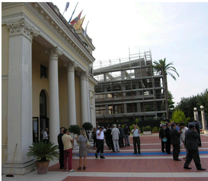
Kursaal con palazzo in costruzione
