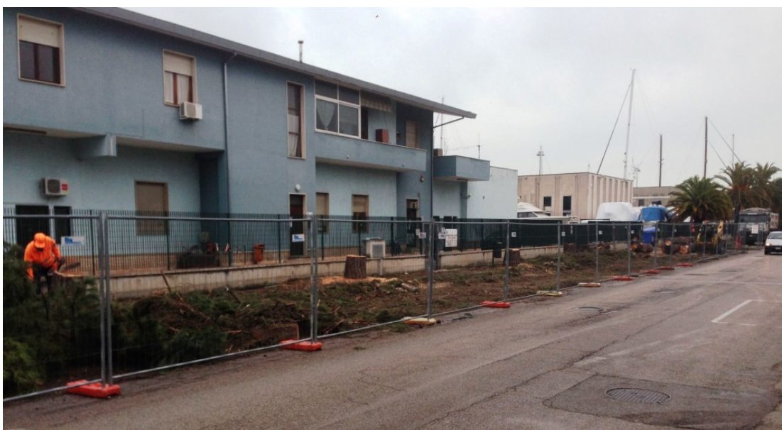
Lavori pista ciclabile Giulianova DOPO
