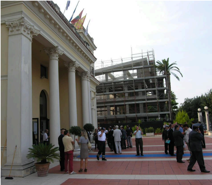
Kursaal con palazzo in costruzione
