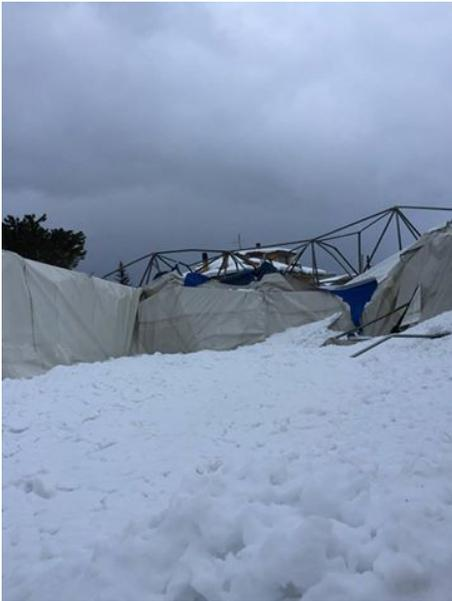
Nessuna azione protettiva, invece, era possibile sulla copertura del campo identificato con il n. 3, quella "storica", realizzata 25 anni fa con una struttura fissa geodetica in tubi di acciaio e, purtroppo, la mole e la particolare pesantezza della coltre nevosa ha provocato il suo crollo nella mattinata di martedì 17 gennaio.
