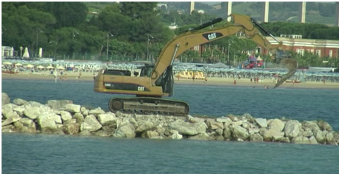
FOTO ARCHIVIO _ FOTO LAVORI AL PORTO
