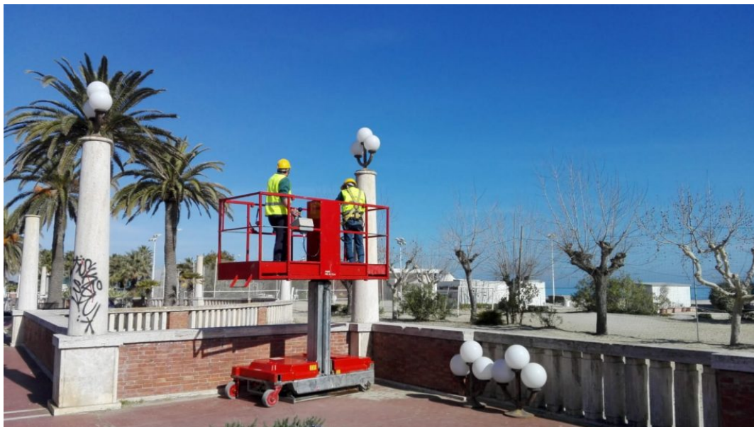
lavori sul lungomare monumentale (1)
