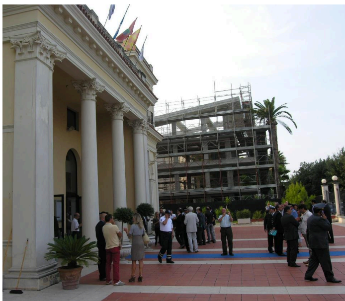
Kursaal con palazzo in costruzione
