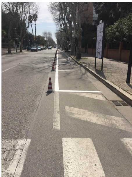
Giulianova, rifacimento segnaletica stradale
