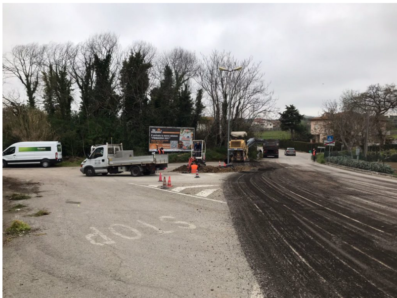
interventi per la realizzazione della rotatoria di via per Mosciano (3)
