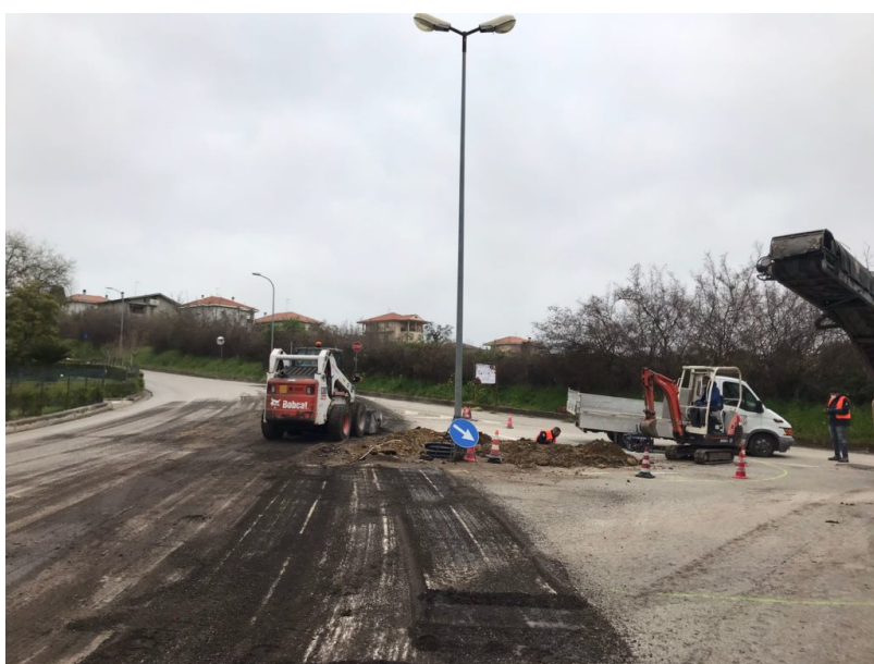
interventi per la realizzazione della rotatoria di via per Mosciano (2)
