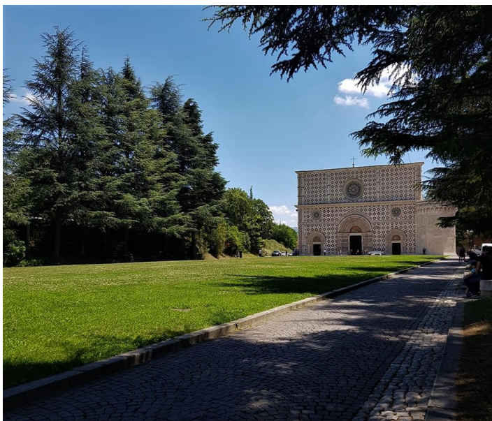
L'Aquila, Santa Maria di Collemaggio
