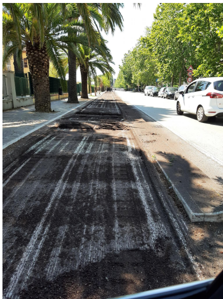
lavori lungomare Spalato
