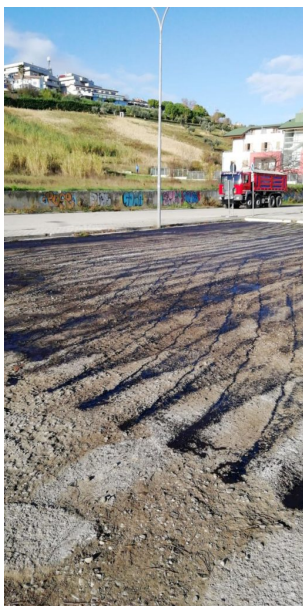
interventi manutenzione asfalto piazza dalla chiesa (3)
