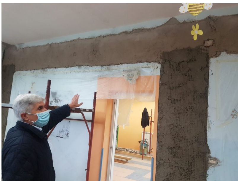
sopralluogo cantiere asilo nido le concinelle (1)
