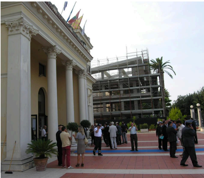
Kursaal con palazzo in costruzione
