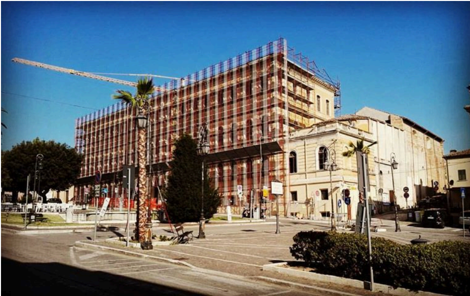
Scuola Edmondo De Amicis di Giulianova - Foto Walter De Berardinis In ristrutturazione
