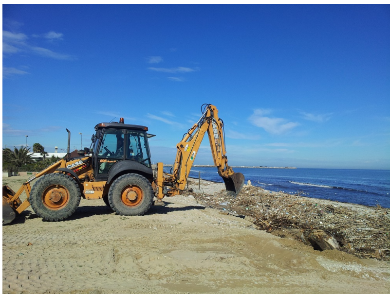
Ruspa spiaggia di Giulianova LAVORI pulizia SPIAGGIA (archivio)
