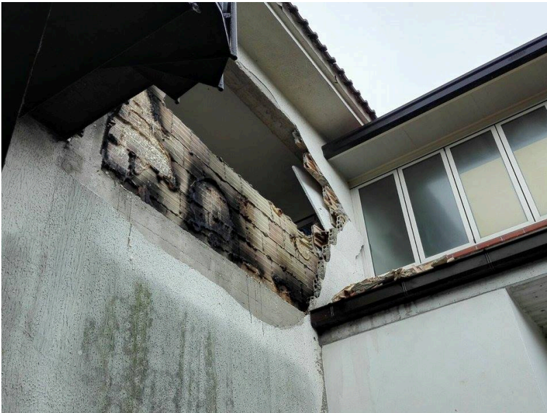
A Martinsicuro, in via Lombardi, è avvenuta un'esplosione all'interno di un locale di un edificio di civile abitazione, che ha provocato il crollo di una parete di tamponamento, vedi foto:
