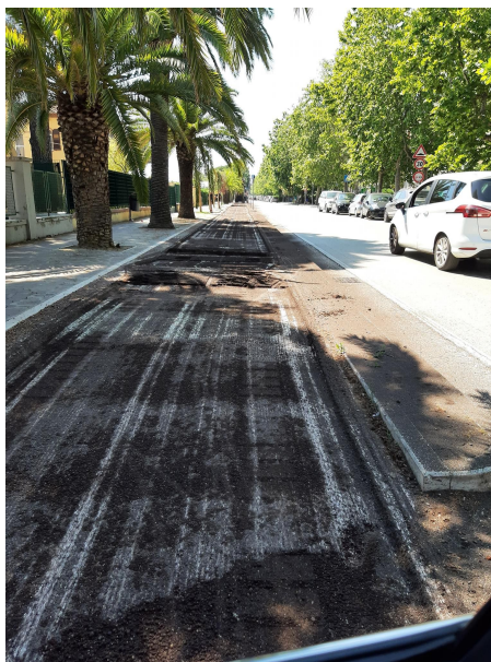
lavori lungomare Spalato
