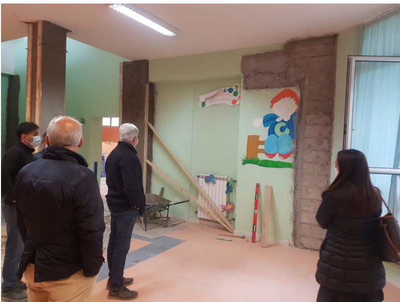
sopralluogo cantiere asilo nido le coccinelle. FOTO ARCHIVIO
