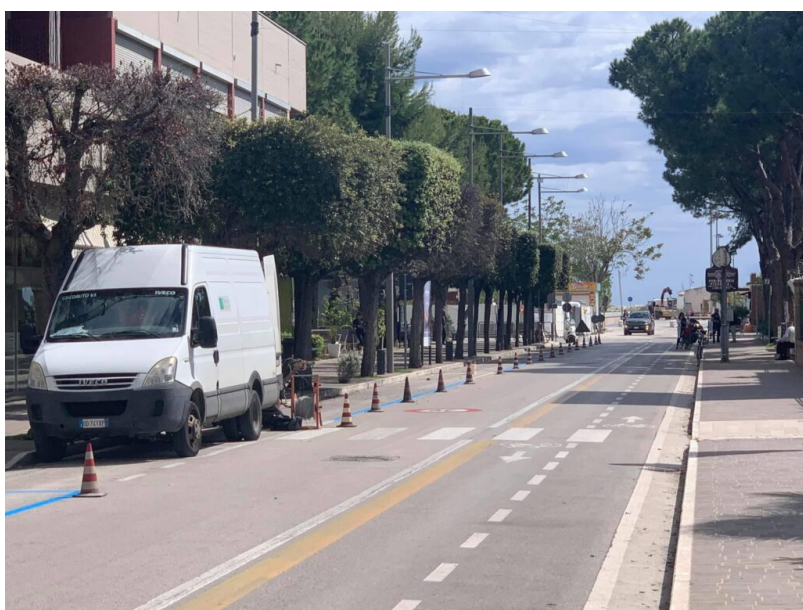
interventi segnaletica orizzontale via Nazario sauro
