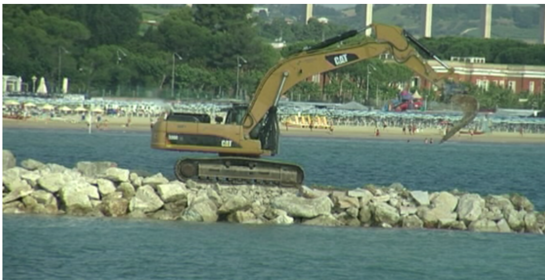
FOTO ARCHIVIO _ FOTO LAVORI AL PORTO
