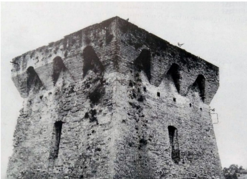
Una foto della torre prima della ristrutturazione
