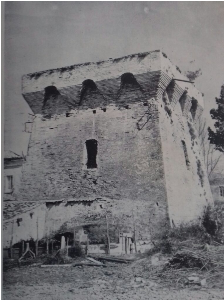
Torre del Salinello
