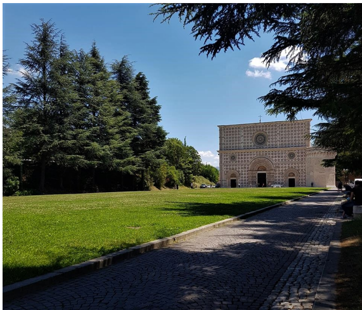
L'Aquila, Santa Maria di Collemaggio FOTO ARCHIVIO
